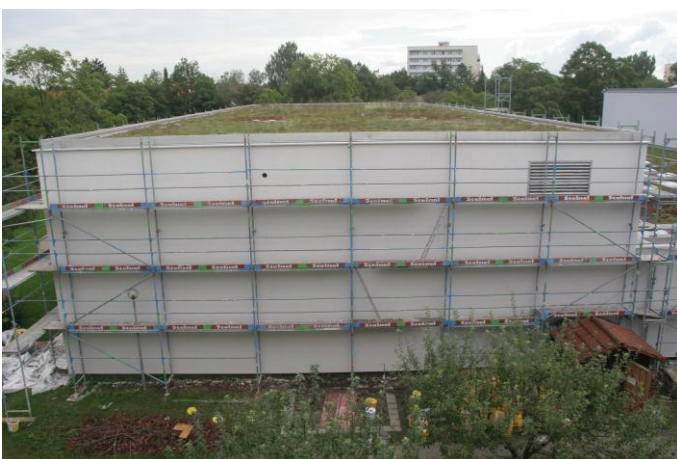
Dämmung der Gebäudehülle
