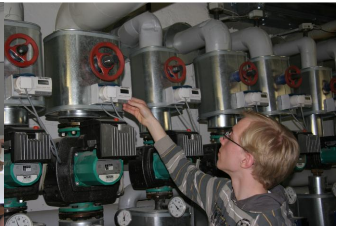
Strommessungen an den Heizungspumpen
